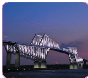
江東区・東京ゲートブリッジ
