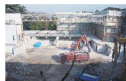
2017年3月時点の解体工事の様子
