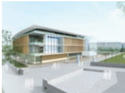
14. 2015年(平成27年) 新1号館竣工予定
