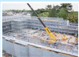
(H28.5.20 時点の進行状況)
